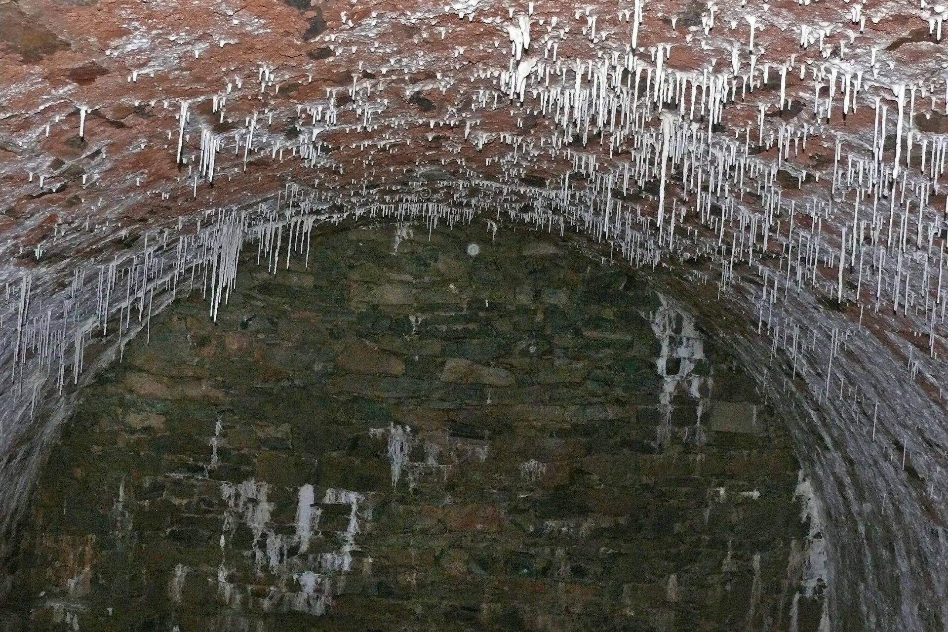
Der Blick in den Hohlraum- das Mauerwerk mit vielen offenen Fugen und von oben her durchsickerndes Wasser. Diese Durchnässung sollte ebenfalls beseitigt werden
