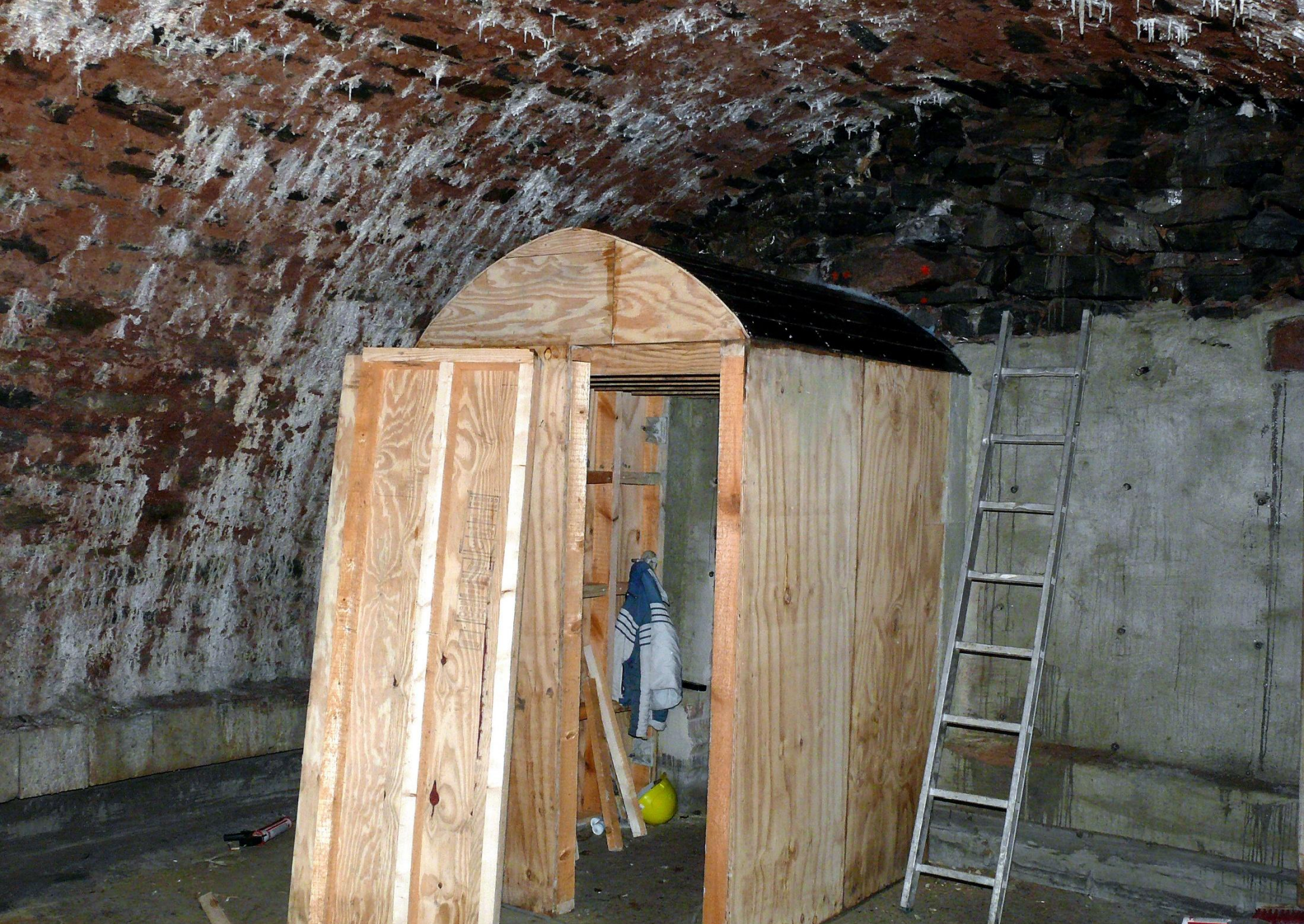
Auf den unteren 6m Beton wurde die Schalung für den Raum innen errichtet
