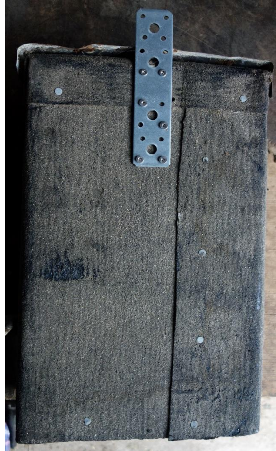
Abb. 3 Kastenaufhängung mittels Flachverbinder
